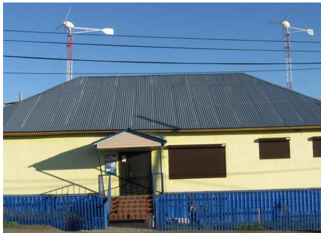
Рис. 2. ВЭС в п. Тура Эвенкийского муниципального района (две ветроустановки Сапсан-500 мощностью 0,5 кВт каждая) [2]
