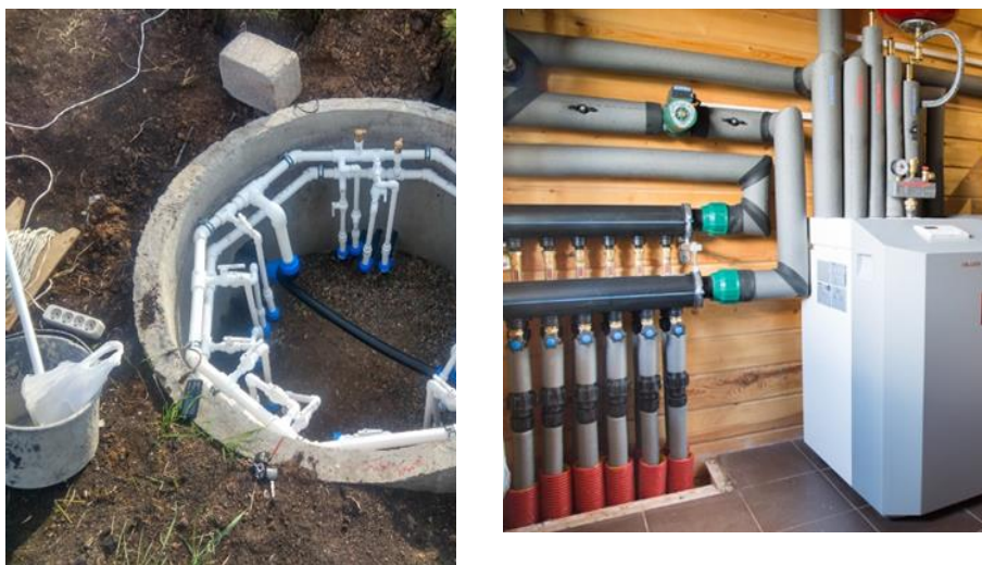
Рис. 8. Теплонасосная система отопления сельского жилого дома [14]
