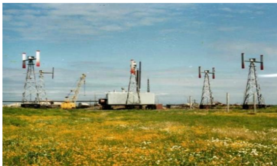
Рис. 1. ВДЭС в п. Левинские пески Таймырского муниципального образования (5 ветроустановок мощностью 20 кВт каждая) [2]
