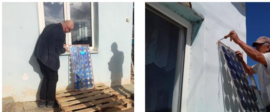
**Рис. 1.** Вариант монтажа солнечного модуля: 1 - наземный, 2 - стена здания. Фото Битяевой Г.Е.
