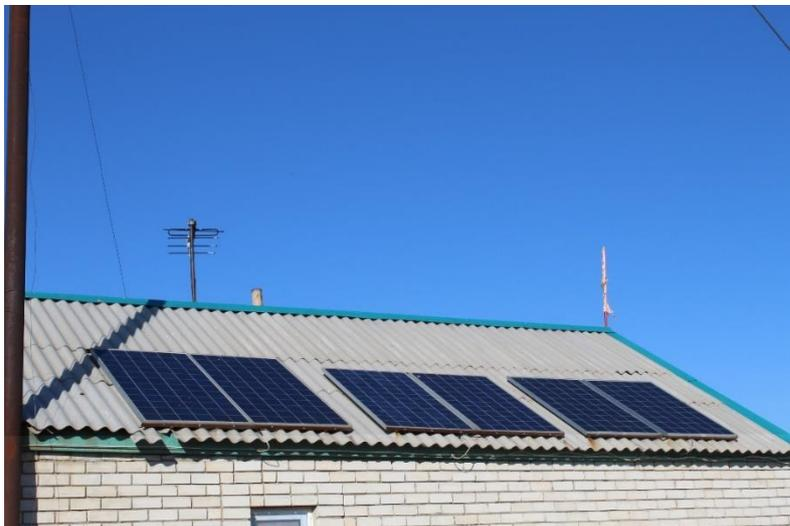
**Рис. 2.** Вариант монтажа солнечного модуля на крыше здания на кордоне заповедника Черные Земли. Фото Сангаджиева М.М.
