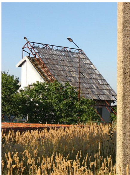
Рис. 9. ФЭП коттеджа в пос. Черноморский
