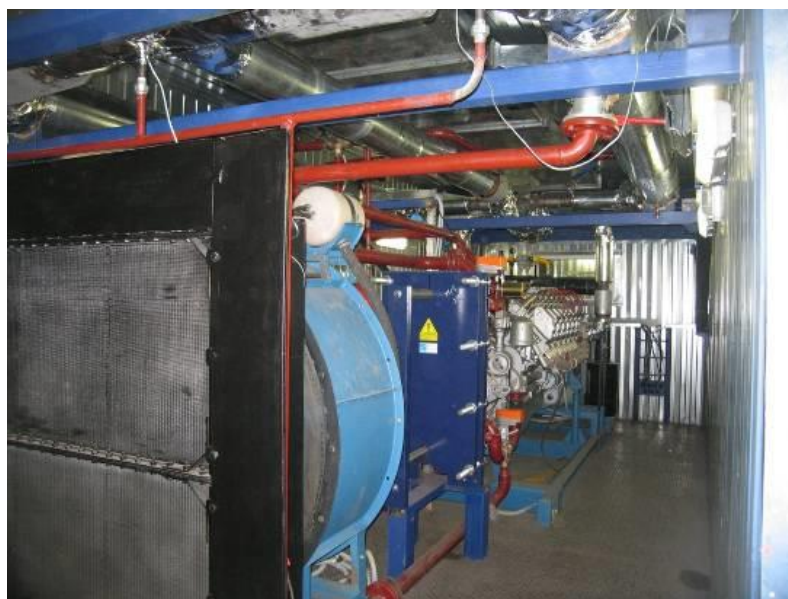
Рис. 4. Мини-ТЭЦ мощностью 315 кВт в контейнерном исполнении
