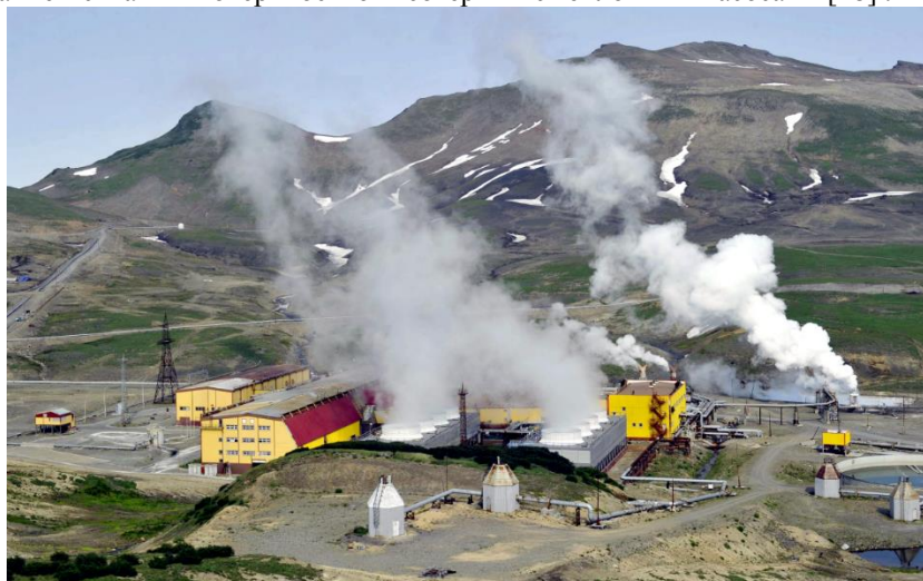
Рис. 2. Мутновская геотермальная электростанция.
